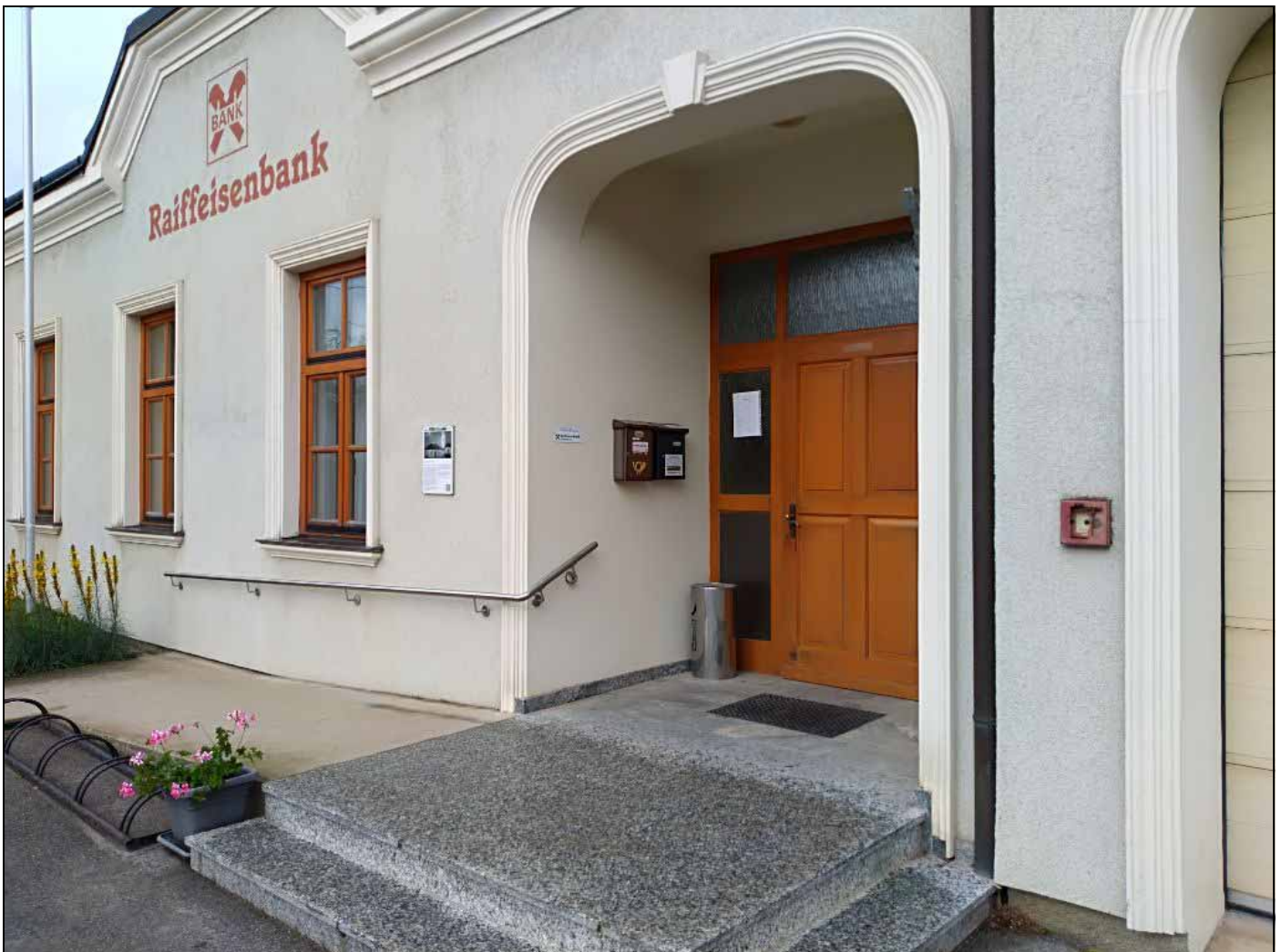
Anbringung des Defibrillators im Eingangsbereich des Feuerwehrhauses
